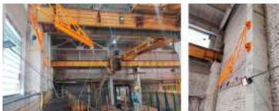
Жесткая горизонтальная анкерная линия ДВУТАВР
